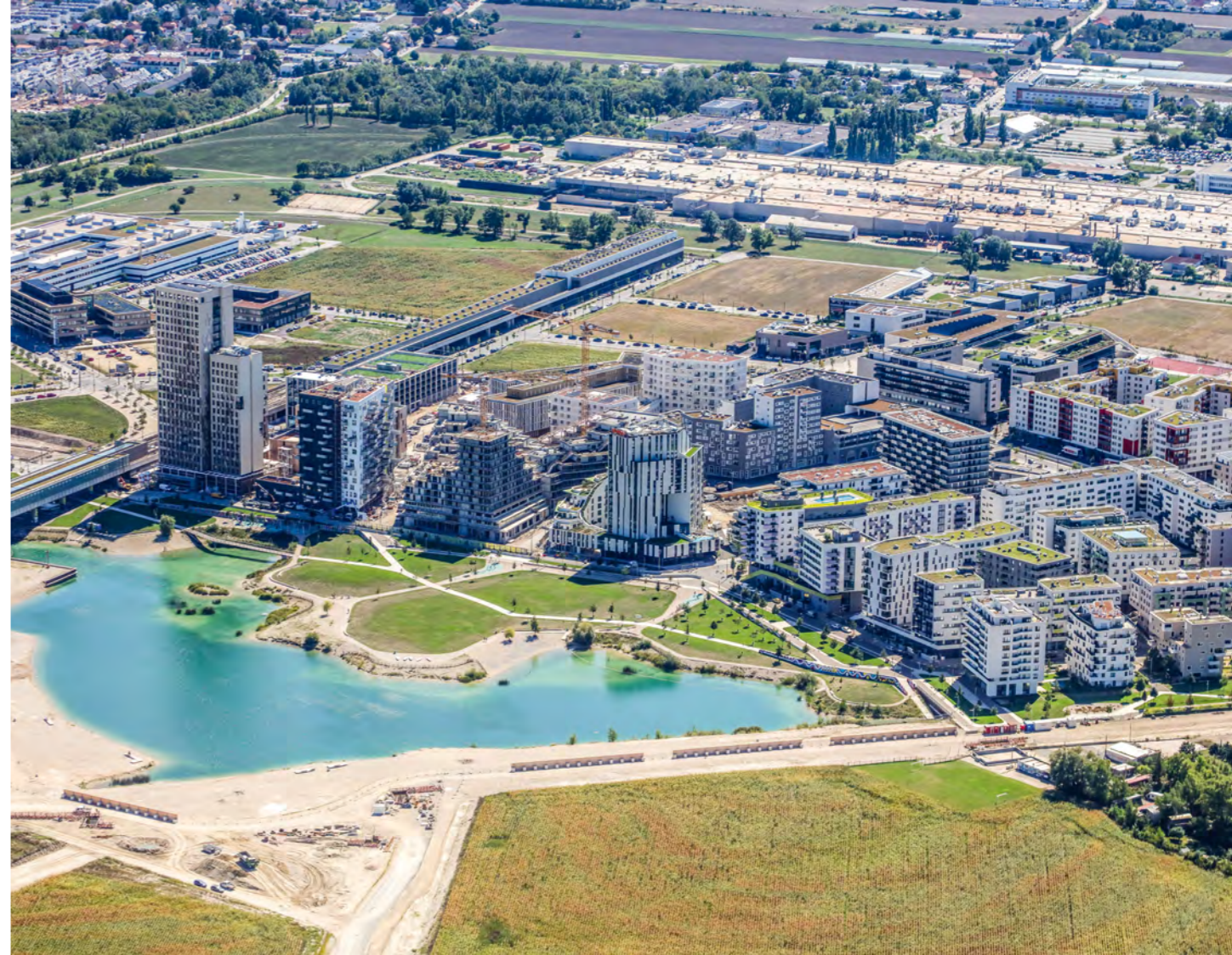
Kies aus dem Seeaushub wird für die Ortbeton Herstellung verwendet © Christian Fürthner | MA 18
